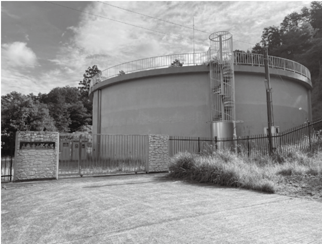
上水道正楽寺配水池
