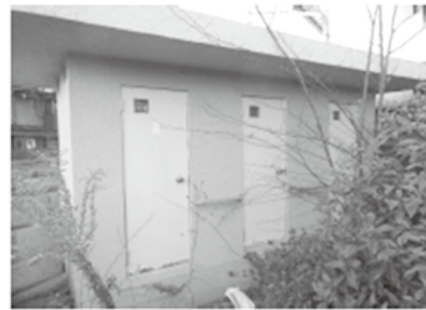
No. ④ トイレ
