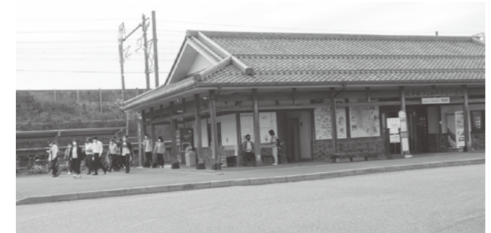
△改修された尼子駅舎(平成15年建設)
